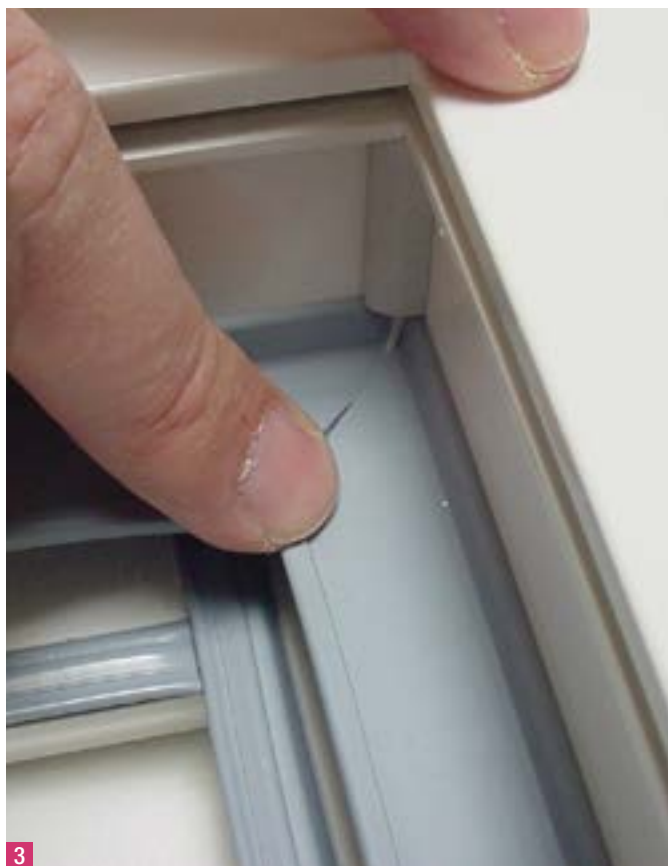
Уплотнения сдвигаются, при этом стык должен быть в одной плоскости.
