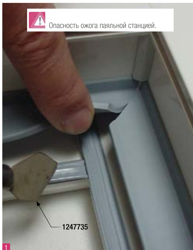
Раскрывается сварной шов центрального уплотнения.
